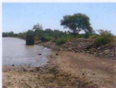
La diga, nelle condizioni attuali.
